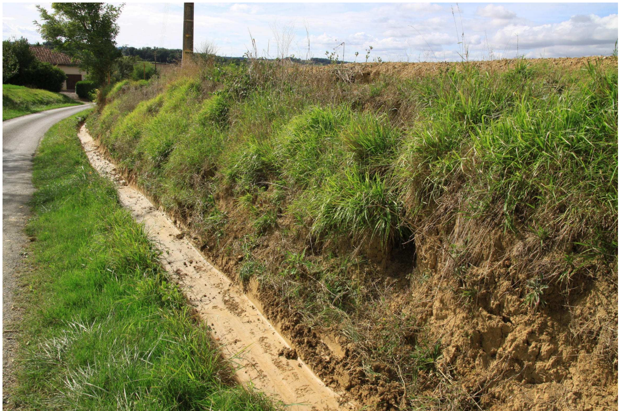
Figure 14 : La pente trop importante du talus et l'absence de haie vont entraîner une importante érosion du talus à chaque forte pluie, lessivant ensuite des matières en suspension jusque dans les cours d'eau © SIRE Conseil
